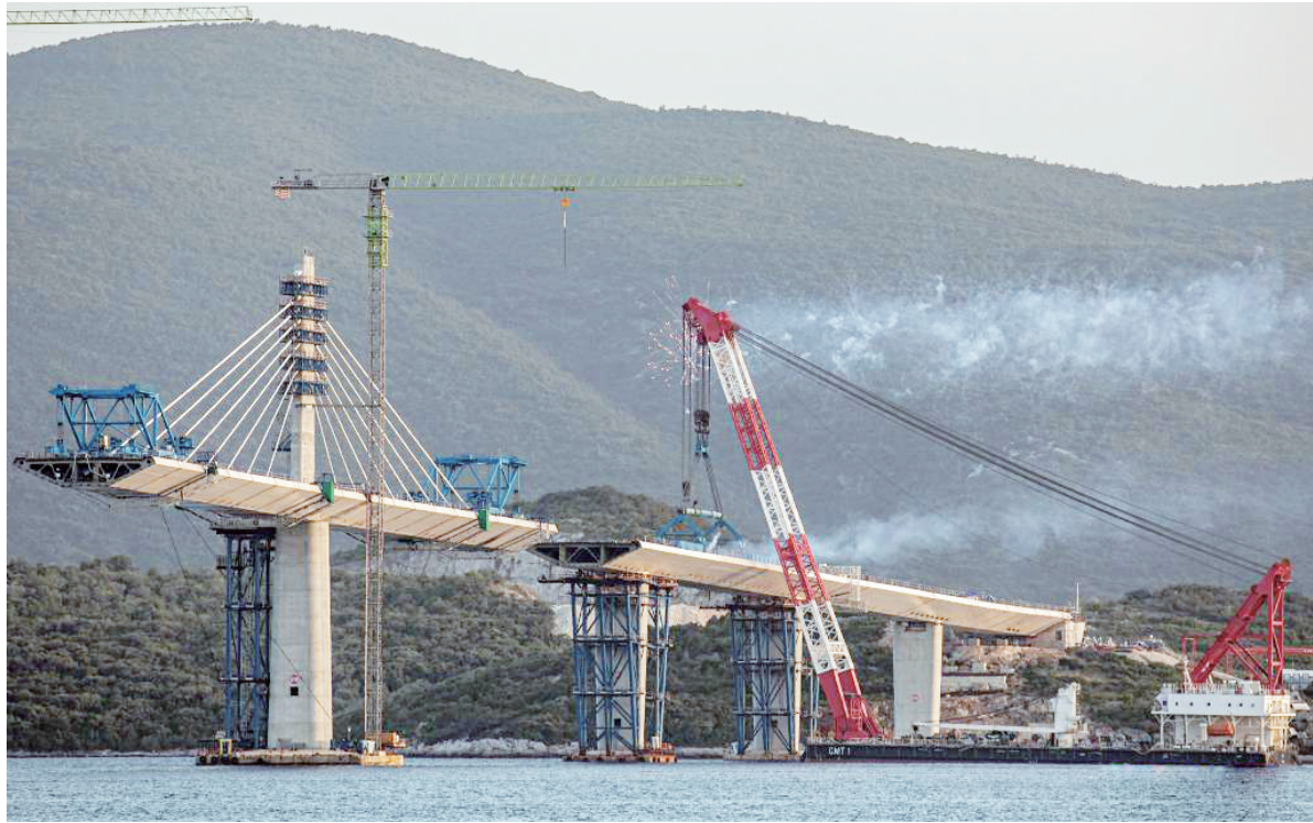
中国路桥公司牵头的中国企业联合体2018年中标并开建克罗地亚佩列沙茨跨海大桥工程项目。大桥设计总长2440米,建成后将横跨亚得里亚海小斯通湾。图为在克罗地亚南部的科马尔纳村附近拍摄的佩列沙茨大桥施工现场。
