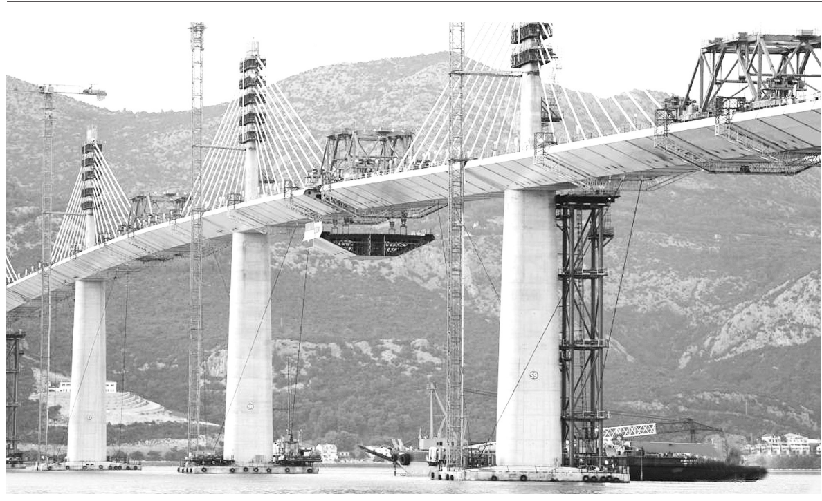
近日,随着中国建设者用桥面吊机把最后一片重达220吨的钢箱梁提升到位并完成焊接,中国企业承建的克罗地亚佩列沙茨跨海大桥成功合龙。佩列沙茨大桥是一座长2440米、宽22.5米的公路斜拉桥,横跨克罗地亚南部亚得里亚海的小斯通湾,连接该国大陆与佩列沙茨半岛。
