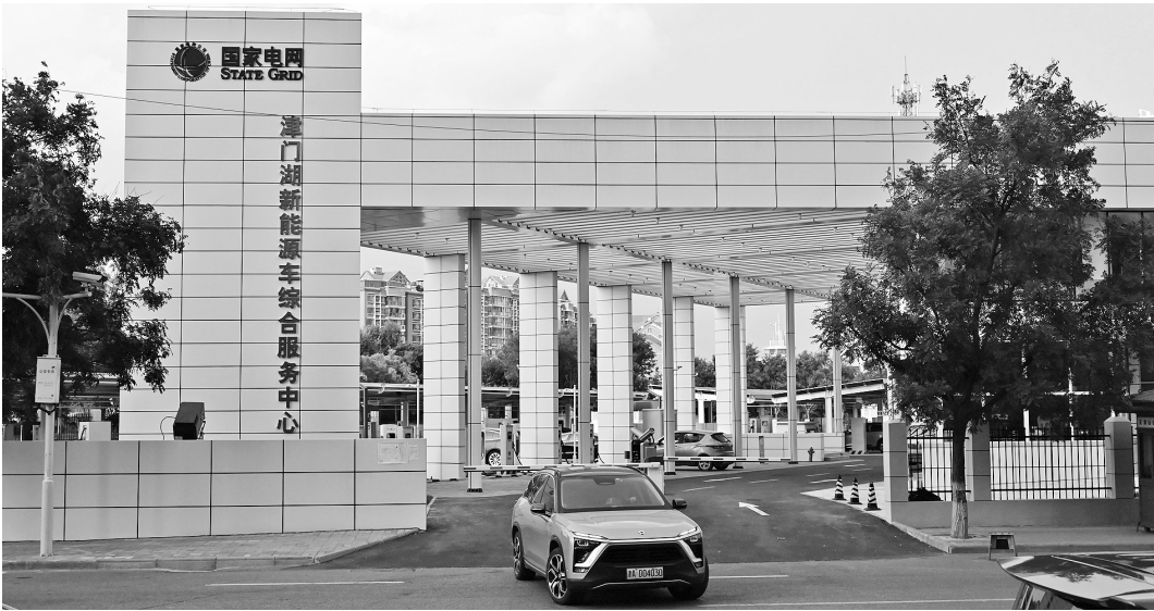
近日,全国首个近“零碳”新能源车综合充电站在天津启用。据介绍,该综合充电站的屋顶、车棚上有光伏板,地下有热泵和满足各式各样充电需求的71个充电车位。该充电站使用了测量传感、智能传输、优化控制等技术,实现了近“零碳”运营,每年预计可减少碳排放约4575吨。
