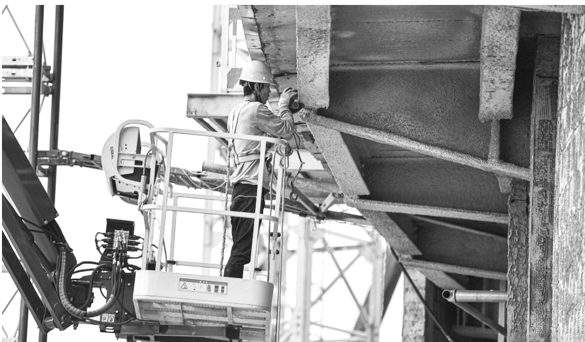
海口国际免税城项目由中建一局承建，目前该项目核心——免税商业中心正在进行屋面网壳和外幕墙施工。免税商业中心建成后，将被打造成以免税为核心，集文化娱乐和餐饮住宿等功能的大型国际免税商业综合体。图为工人在该项目工地施工。
