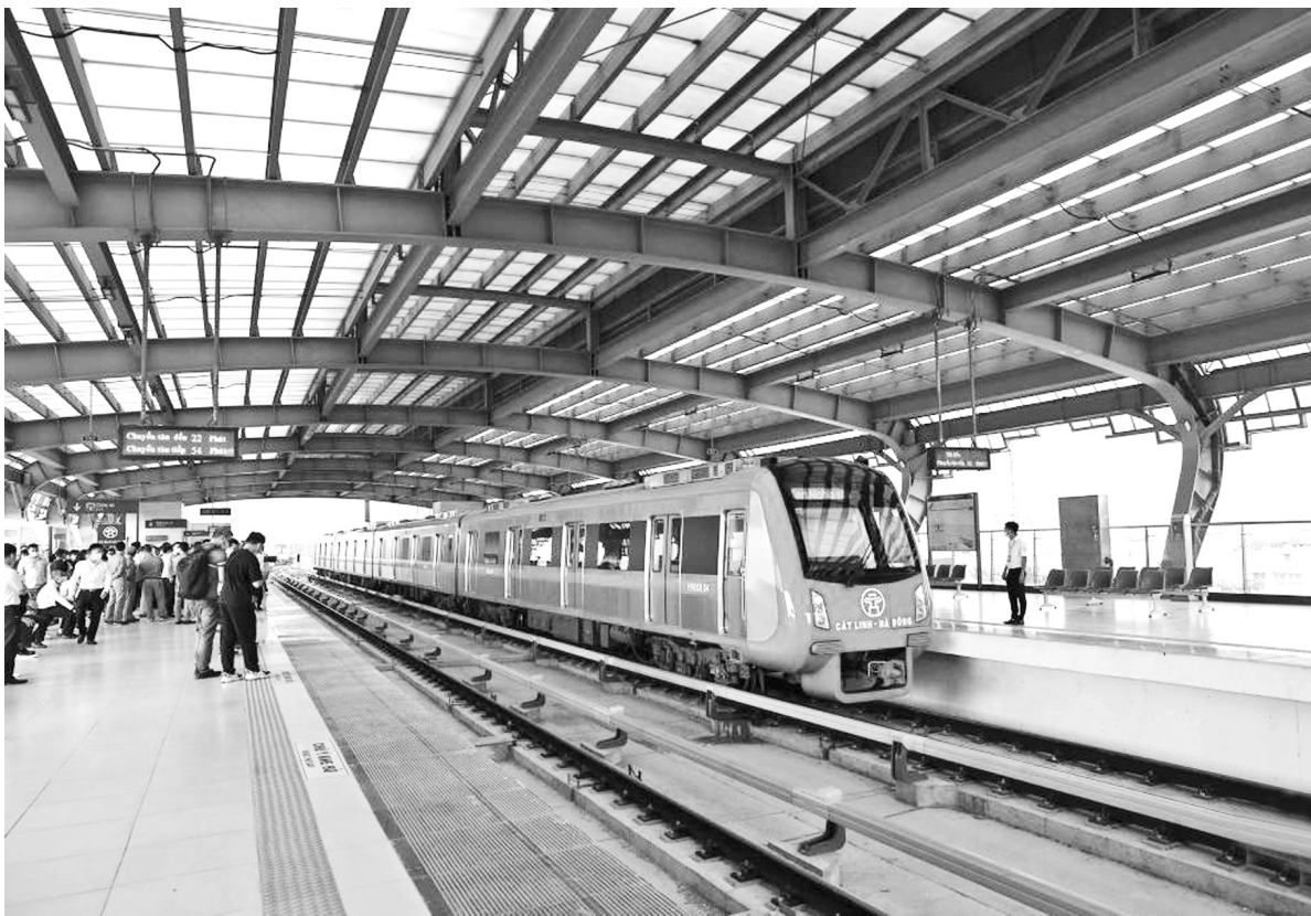
中企承建的越南首条城市轻轨项目吉灵—河东轻轨线交接仪式 11 月 6 日在越南首都河内举行,标志着该项目投入运行。该项目对完善河内城市路网功能,缓解交通压力,促进区域经济发展有重要意义。图为在越南首都河内拍摄的吉灵—河东轻轨线吉灵站。 新华社 越通社
