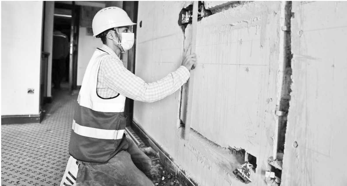
埃及开罗“城市之星”是集商场、酒店、公寓、写字楼为一体的大型综合体。2021年初,中国化学工程第十六建设有限公司承接了“城市之星”翻新装修工程。图为一名埃及工人在该项目施工现场工作。
