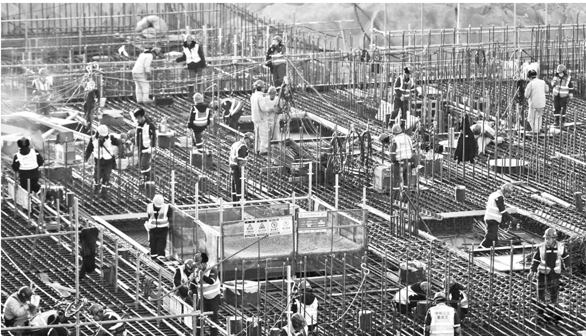
11月29日,“帕兰道夫斯基”号货轮驶入辽宁葫芦岛港,随着沈阳海关所属葫芦岛海关两名关员对其运载的从俄罗斯进口核电设备完成现场监管,中俄核能合作项目——徐大堡核电首批俄供大件设备顺利通关,即将运往几十公里外的徐大堡核电站施工现场进行安装。图为徐大堡核电站3号机组施工作业现场。 新华社记者 杨青 摄
