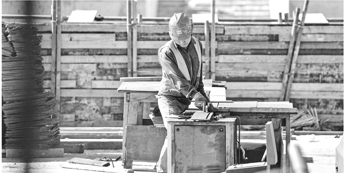
目前,在海南自贸港重点园区——洋浦经济开发区,由中国能建葛洲坝二公司建设的洋浦国际航运大厦项目施工有序推进。目前,该大厦已完成基础结构和群楼主体结构施工,正在进行塔楼主体结构施工。项目建成后,洋浦国际航运大厦将成为洋浦地标性建筑和行政、商贸中心。图为工人在该项目工地施工。新华社记者 蒲晓旭 摄
