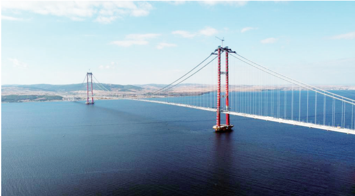
由蜀道集团下属四川路桥参与建设的世界主跨最大桥梁土耳其1915恰纳卡莱大桥3月18日举行通车仪式。土耳其总统埃尔多安在通车仪式上表示，该桥建设为土耳其经济发展和创造就业做出贡献，通车后将在节能减排和时间成本收益方面每年为土耳其节省约4.15亿欧元。
