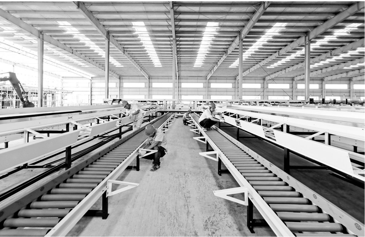
位于四川省眉山市仁寿县的川果智慧冷链物流中心,是一个集水果“仓储、冷链、加工、分拣”等功能于一体、配备完善的现代化物流配送服务中心。项目建成后,将成为川渝地区最大水果分选及冷链仓储基地。图为工人们正在进行水果分选设备安装。
