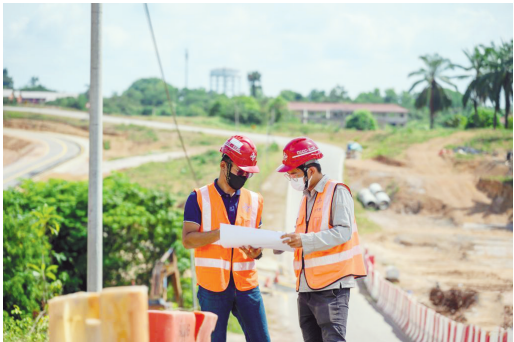
图为7月25日，西亚赫明(左)在位于马来西亚彭亨州的马东铁项目六分部施工现场工作。
