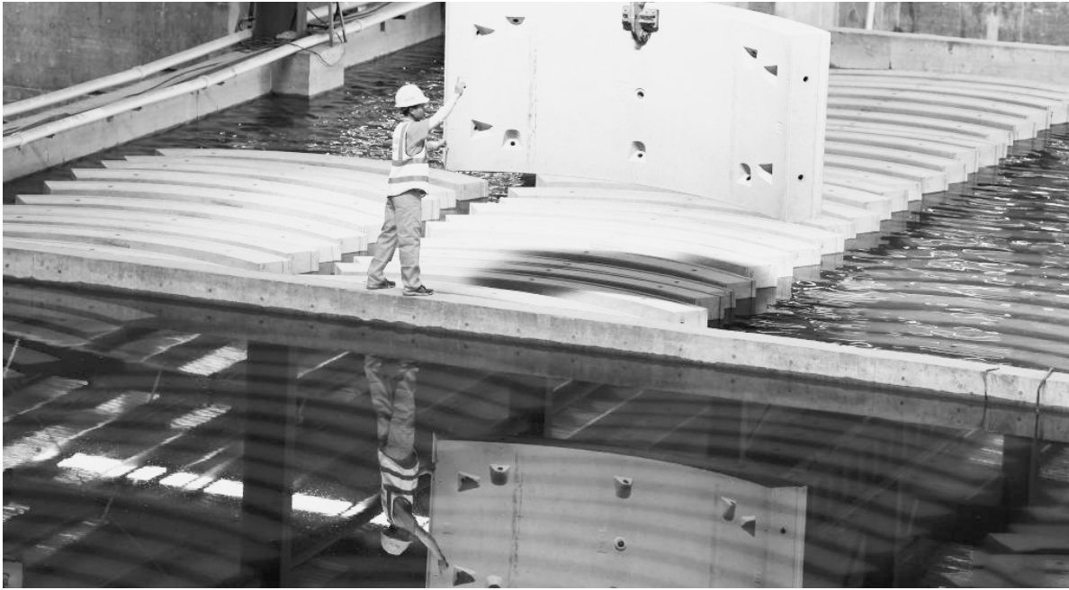
安徽淮南近日持续高温,中铁四局安徽智能制造有限公司盾构管片制造基地采取错时施工、发放防暑用品等措施,保护高温下劳动者的安全,确保地铁建设所需盾构管片的生产进度。图为工人在中铁四局安徽智能制造有限公司盾构管片制造基地忙碌。
