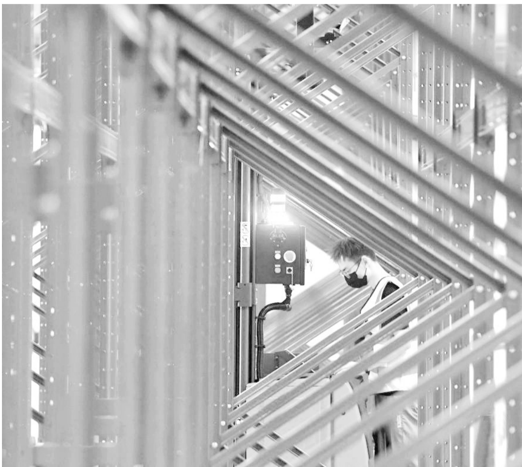
郑州新郑国际机场北货运区8月16日开始试运营。据了解,该货运区总建筑面积共16万平方米,新建货机位16个、冷链中心3000平方米、生鲜水果和食用水生动物查验区4500平方米。北货运区投运后,郑州机场货运站总面积将达到19.8万平方米,货机位25个,年货邮保障能力将达到110万吨。图为工作人员在调试自动化导引叉车。
