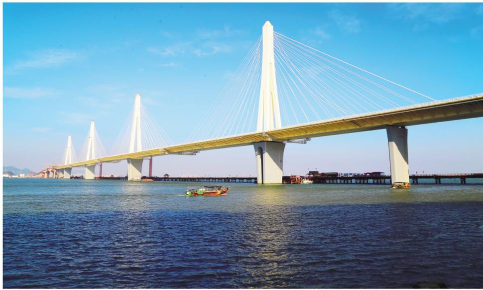
9月5日, 广东珠海, 粤港澳大湾区重点工程——珠机城际金海特大桥主跨钢梁10时18分成功合龙。金海大桥是世界首座公铁同层多塔斜拉桥, 同时也凭借49.6米的桥面宽度, 创造了目前公铁两用多塔斜拉桥宽度的世界纪录。图为近日拍摄的大桥合龙施工现场。
