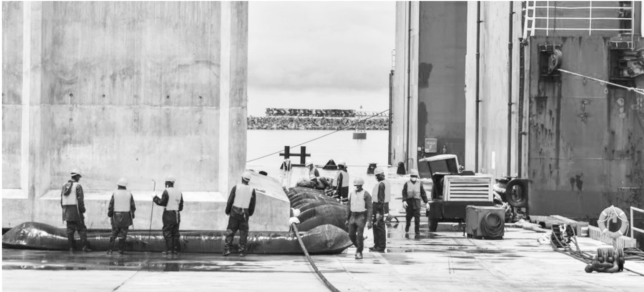
由中企建设的喀麦隆克里比深水港日前举行二期项目首批沉箱出运安装仪式，标志着该项目码头主体进入实质性施工阶段。图为工人在喀麦隆克里比进行沉箱安装作业。 新华社发 科普索 摄
