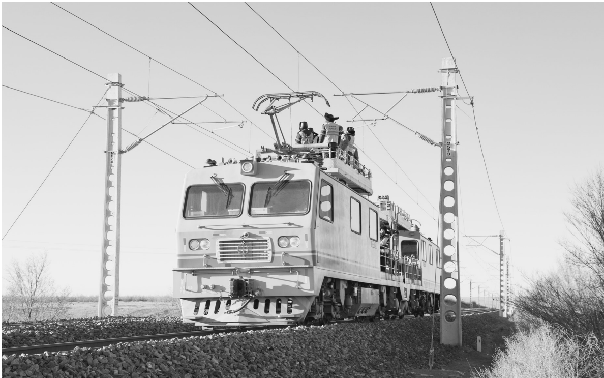
集通铁路是内蒙古自治区的重要铁路干线,西起集二铁路的贾各站,东接通霍铁路的哲里木站,途经内蒙古4个盟市、13个旗县,是连接我国东北、华北、西北地区的重要铁路干线,也是“蒙煤东运”的重要能源通道。图为由中铁电气化局承建的集通铁路贾各至蒙根塔拉段接触网工程开始冷滑试验。
