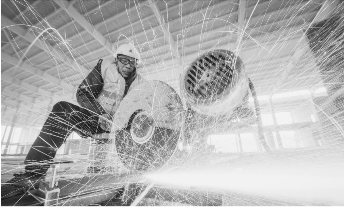
元宵佳节,各行各业的许多劳动者们仍坚守在岗位上。不少地方还开展丰富多彩的慰问、联欢等活动,共度佳节。图为在中建三局三公司承建的湖北省孝感楚能新能源项目工地,工人在切割角钢。 新华社记者 伍志尊 摄
