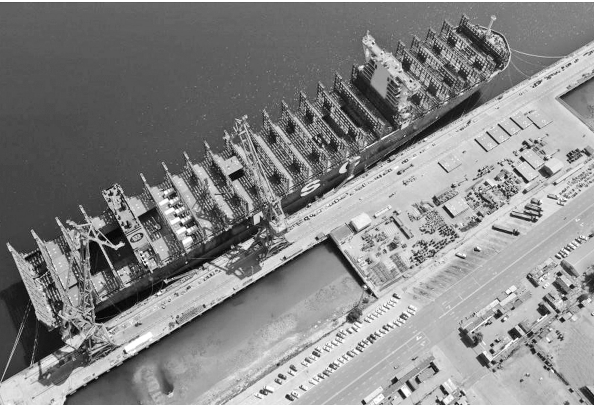
近日,位于天津港保税区的中船(天津)船舶制造有限公司厂区内一片繁忙,船坞内、车间里多艘大型船舶同时处于建造阶段。中船(天津)船舶制造有限公司是中国船舶集团大连船舶重工集团有限公司在天津建立的造船基地,主要建造大型原油轮、大型集装箱船、大型散货船。今年以来,来自法国等国家的集装箱船订单不断,生产订单已排至2027年。图为在该公司厂区拍摄的一艘已经下水准备交付的船舶。
