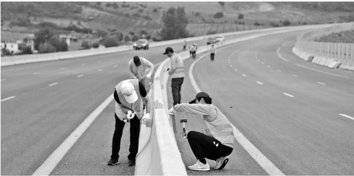
中国中信建设有限责任公司承建的阿尔及利亚东西高速公路东标段84公里项目通车仪式近日在阿尔及利亚塔夫省举行。该路段西起塔夫省雷德安,东至毗邻突尼斯的边境城镇拉姆勒苏格。它的竣工通车标志着连接阿尔及利亚北部17个省、全长1216公里的阿东西高速公路全线贯通。
